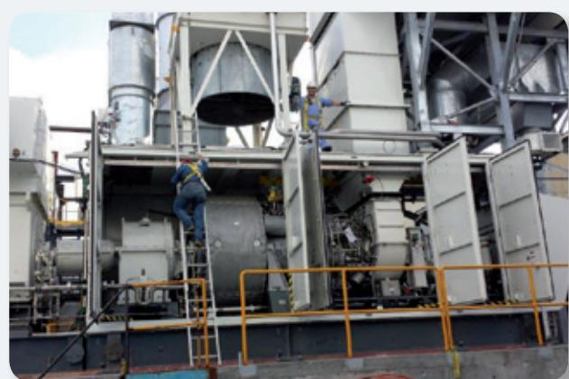
En el segundo eje se encuentra la turbina de potencia (baja presión), de dos etapas, con 9.500 rpm de velocidad de rotación.
